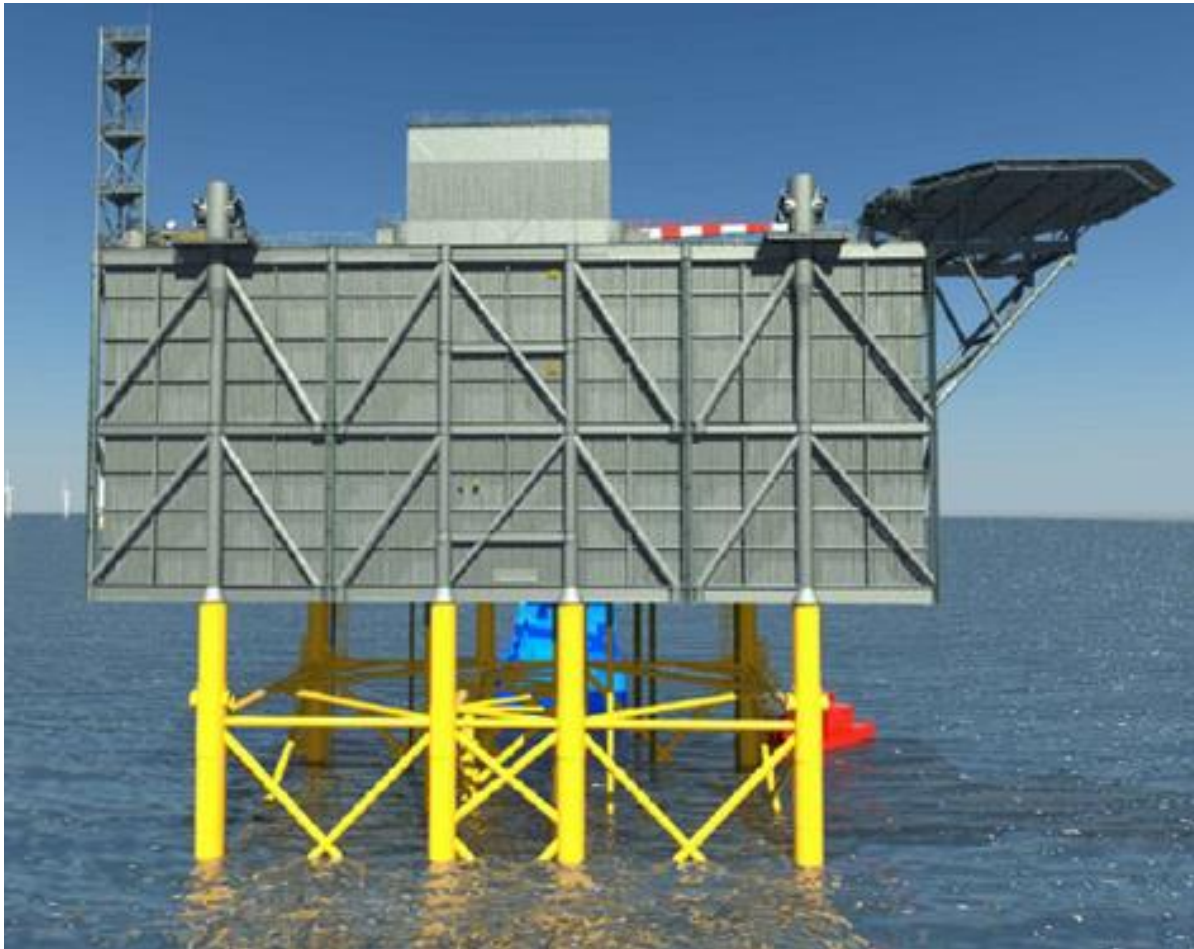
Figur 7-3 Transformatorstation grundlagd med ett fackverksfundament (källa RWE).
